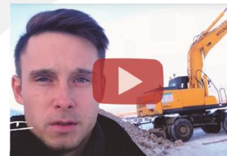
Разработка котлована и установка свай
