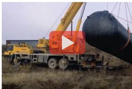
Погрузка и перевозка цистерны 18 тонн
