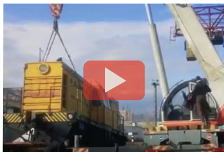
Поднятие и установка на вагон путевой ремонтно-сварочной машины
